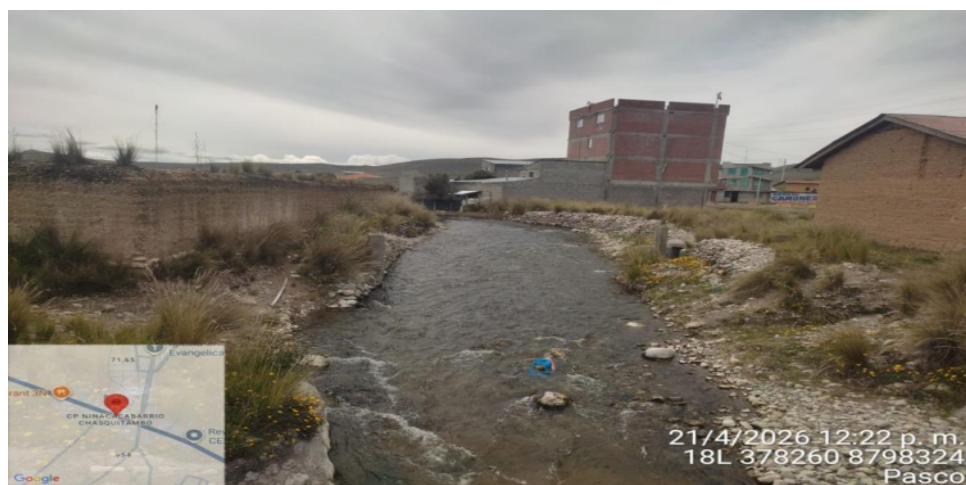
IMAGEN 04: SE OBSERVA AL FINAL DE TRAMO QUE LA MARGEN IZQUIERDA ES VULNERABLE A INUNDACION POR LO QUE SE PROPONE UNA ESTRUCTURA DE MURO DE CONCRETO ARMADO COMO MEDIDA DE PROTECCION.
